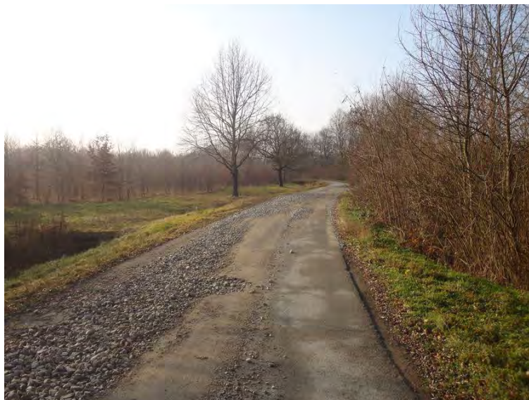
Slika 2.4.8 Postojeće stanje lokalne ceste 33139, izvor: Tenzor, 2014.
